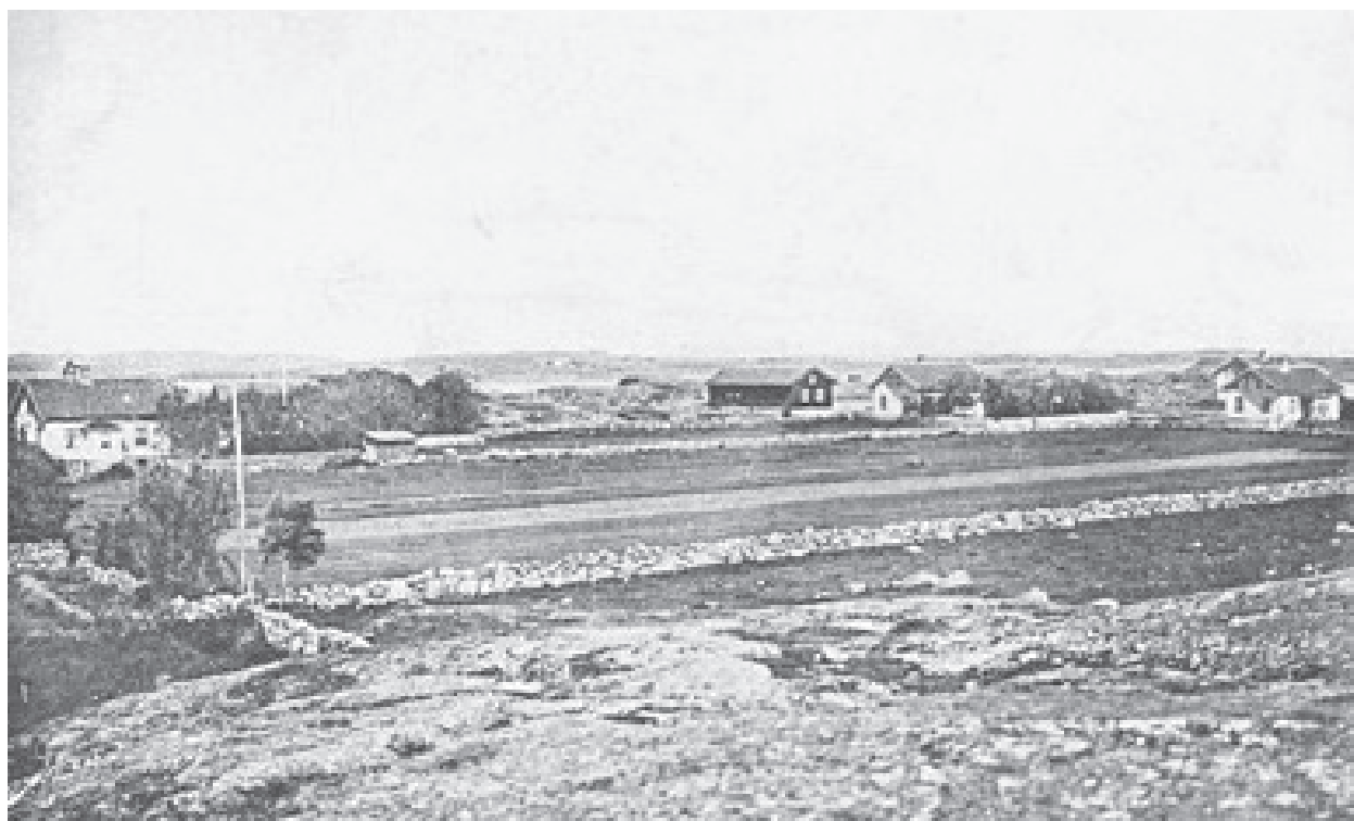
Figur 13 : Från Nästås mot nuvarande småbåtshamnen. Till höger Erikes-Kalles (min farfarsfars) och därbakom Tobis-Annis, sedan Olle Hedströms med den stora ladan, och längst till vänster Yngves och Fritjofs. Till höger om deras, dolt i trädningen, Lille-Larses. Från nätet: VG-region, Västarvet, Bilder.
